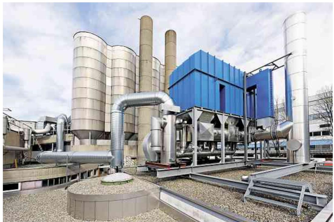
Wannerit AG in Bilten: Die regenerative Nachverbrennungsanlage im Produktionsbetrieb macht Brennstoffe fast überflüssig.
